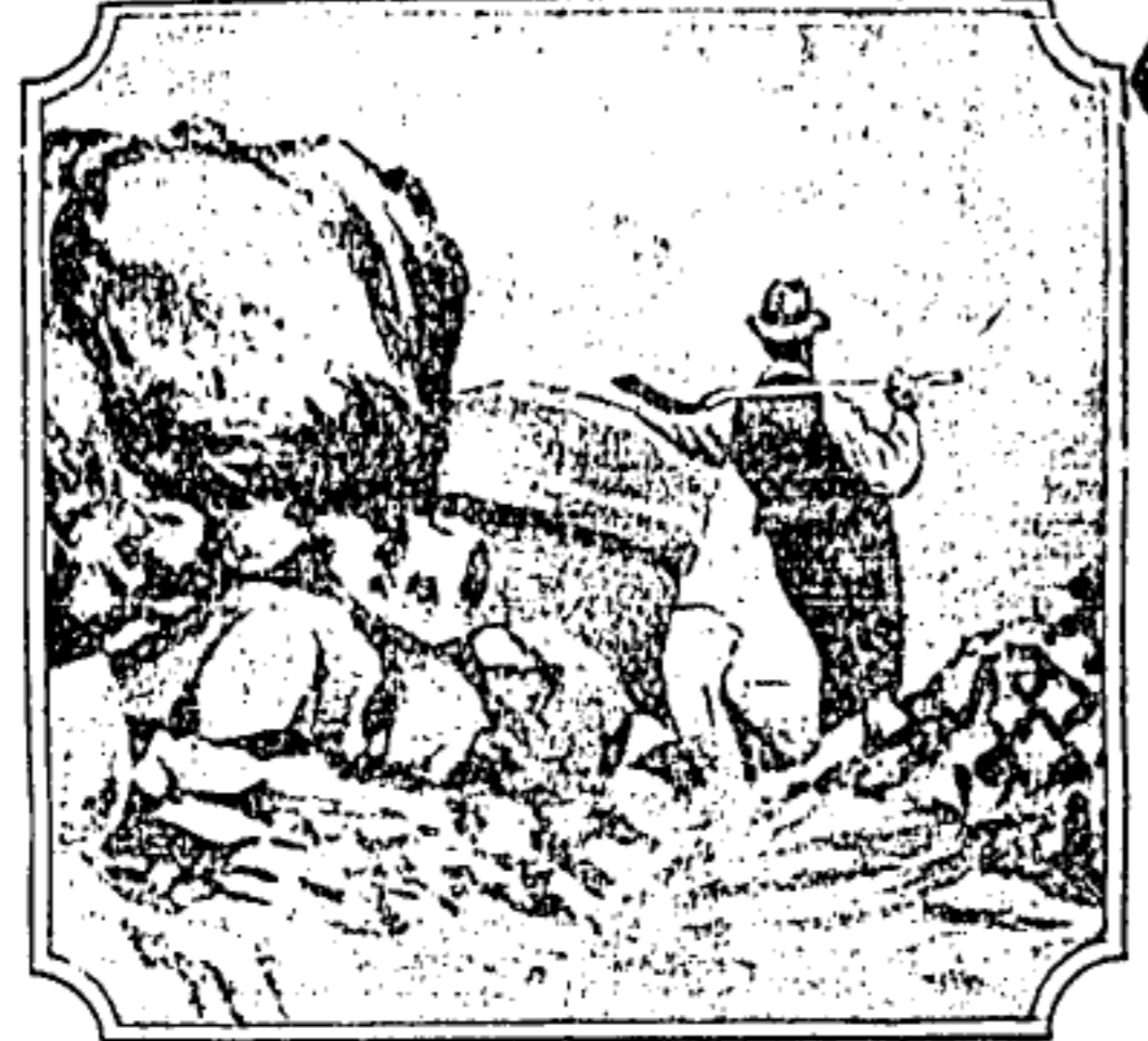
EL ESTADO ACTUAL DE LOS TRABAJOS
