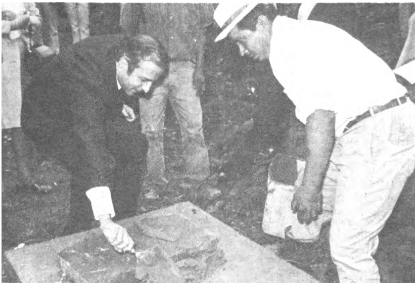
La primera piedra del edificio que será construido para el Colegio de Psicología de la Facultad de Filosofía y Letras, fué colocada por el Rector de la UNAM, doctor Pablo González Casanova, durante un acto efectuado recientemente.
