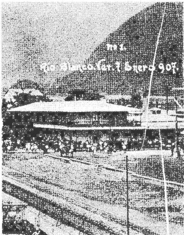
Antes del Incendio
