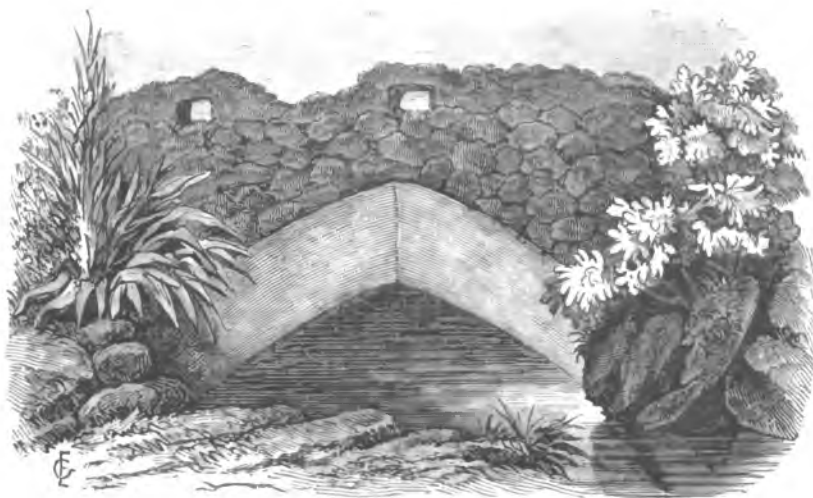
Istmo. — Puente de Chilmatlán
