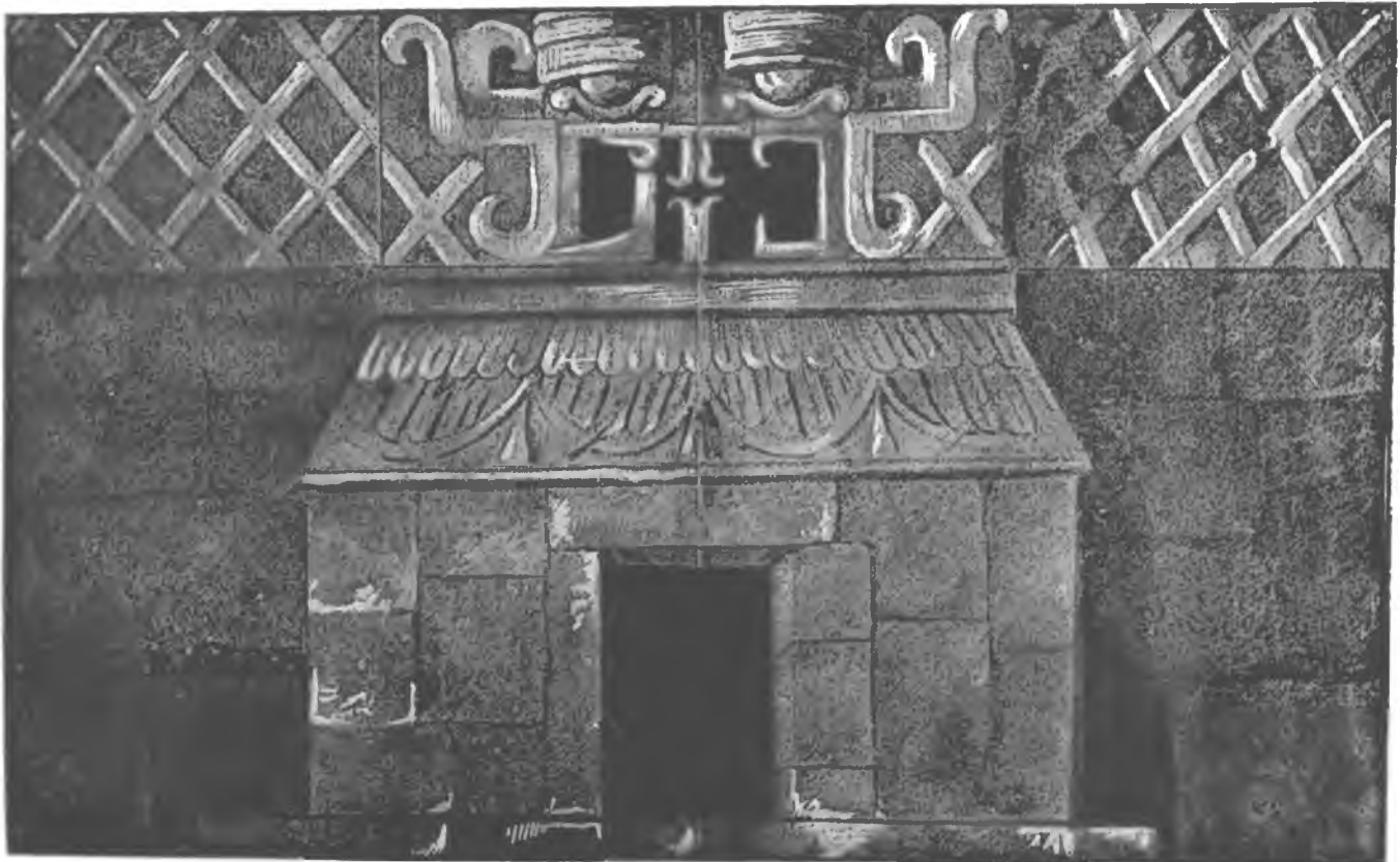
Interior de la Casa de las Monjas—Ala que mira al norte
