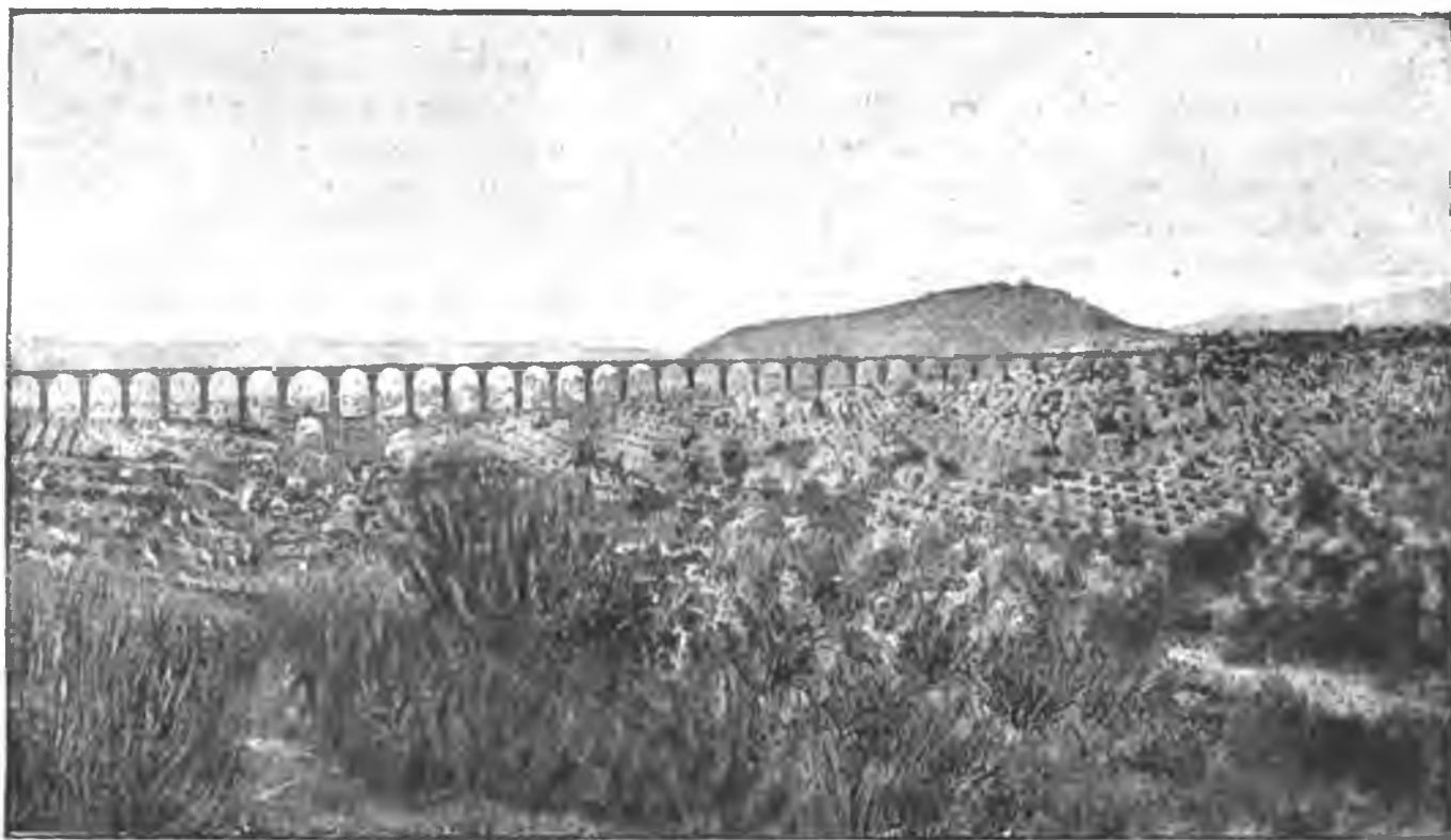
Acueducto de Zempoula
