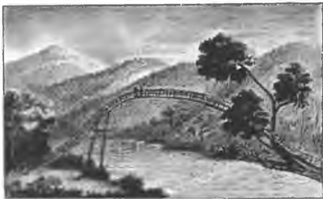
Puente de bejuco sobre el río Necaxa
