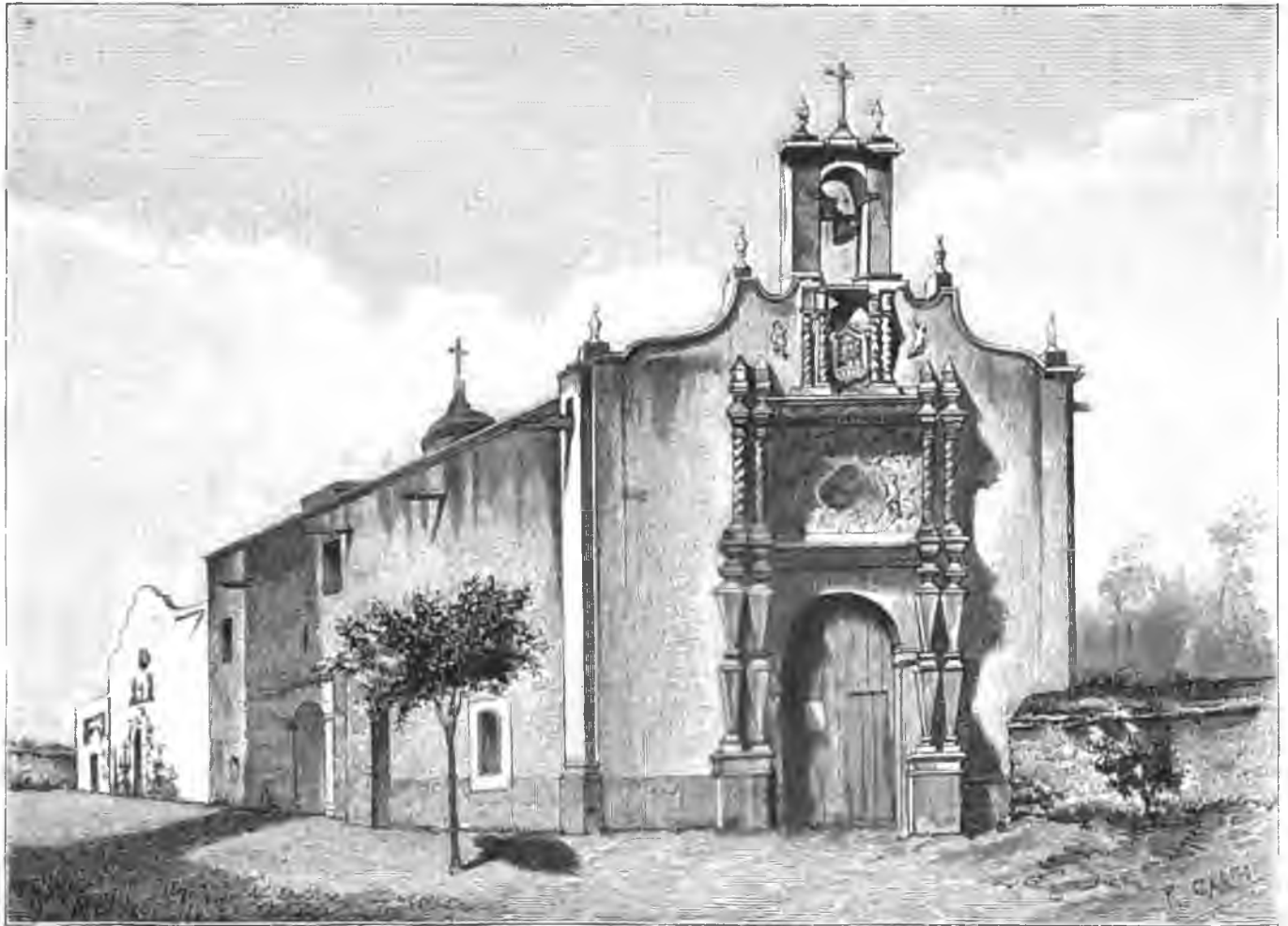
La Hermandad.—Primer templo construido en Texcoco por orden de Hernán Cortés. (Estado actual)
